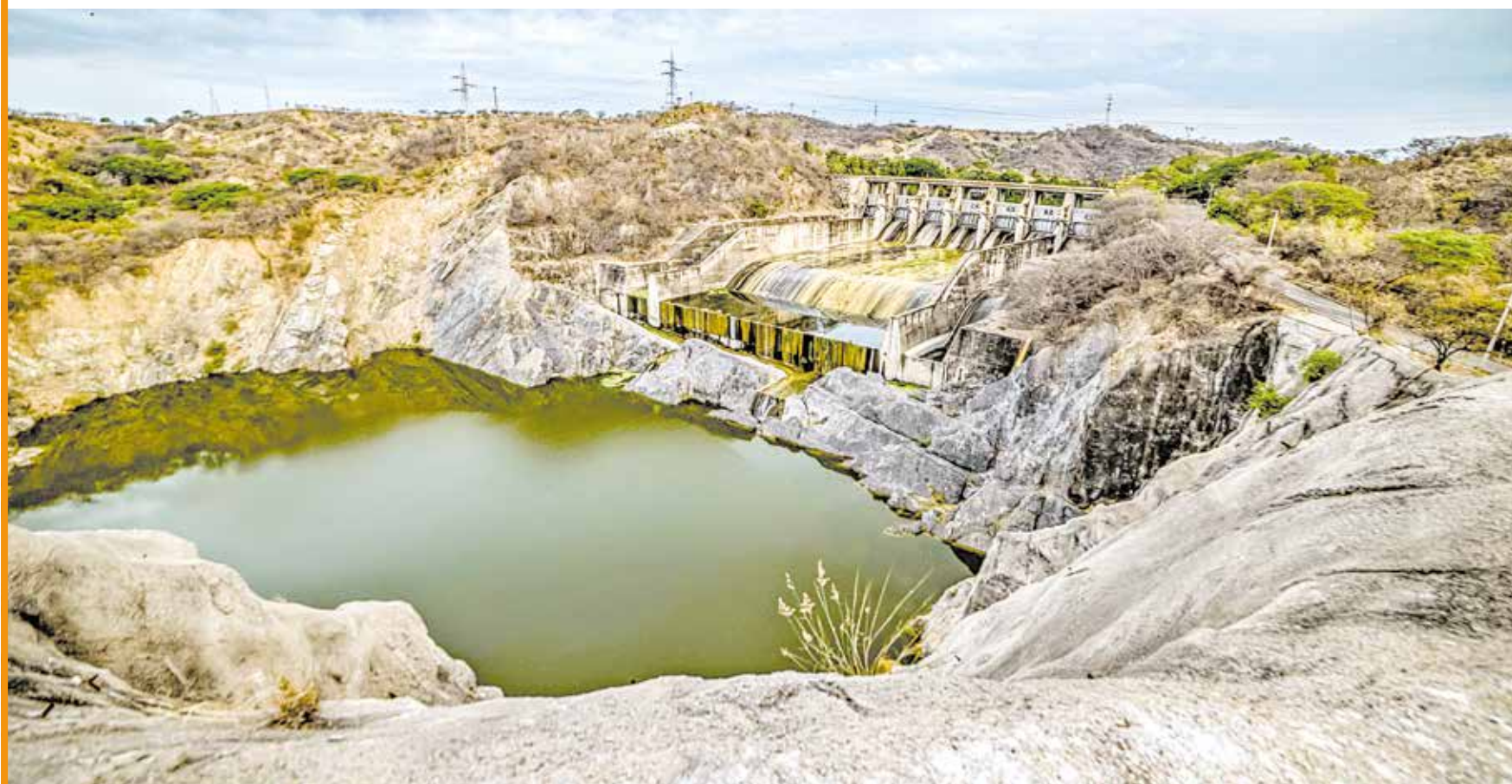
La Villita, en Michoacán, es una de las centrales en proceso de modernización
