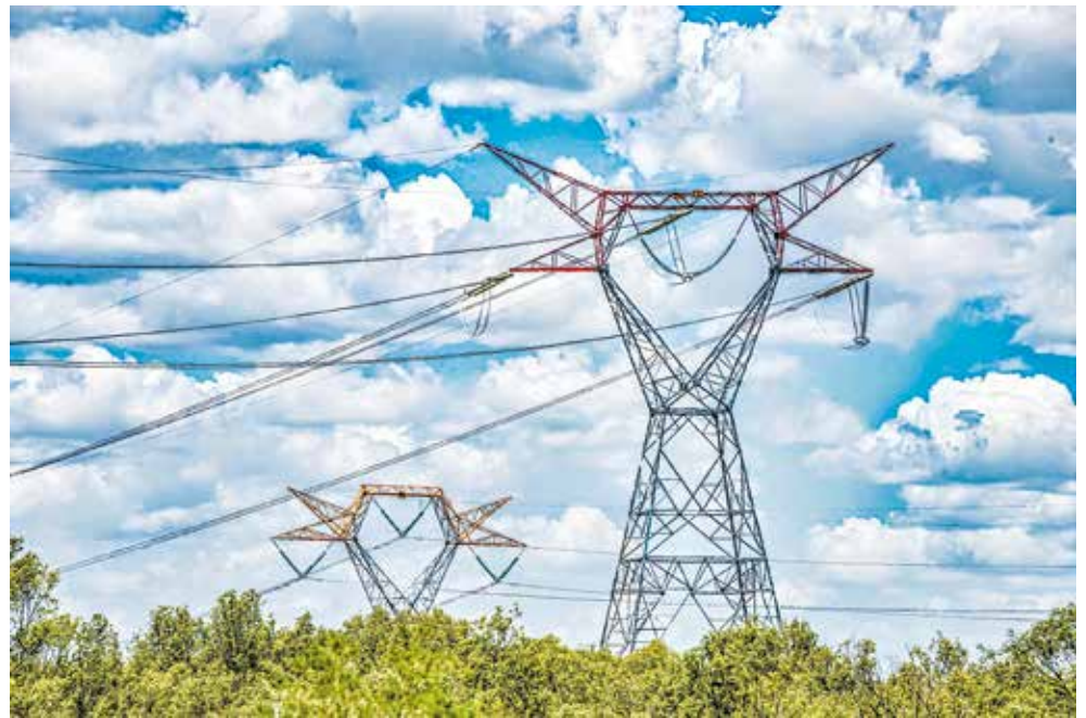
La altura de las torres puede ir de 60 a 137 metros
