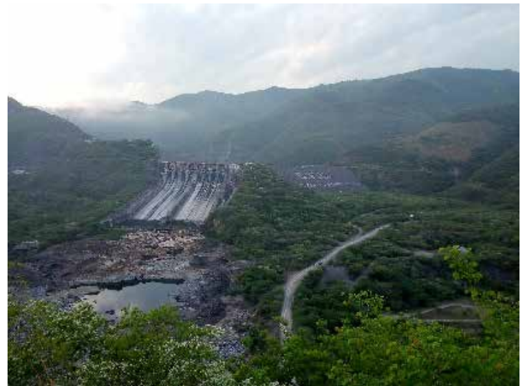
Rocío Ivette Coronado Bello, Dirección Corporativa de Ingeniería y Proyectos de Infraestructura. 2019. La Central Hidroeléctrica El Caracol o Ingeniero Carlos Ramírez Ulloa, ubicada sobre el cauce del río Balsas, en Apaxtla, Guerrero.
